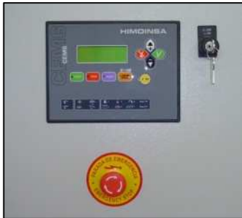
Netzausfall-Automatik CEA7 / Wandmontage
