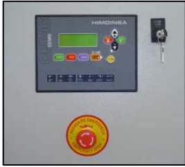
Netzausfall-Automatik CEA7 / Wandmontage
